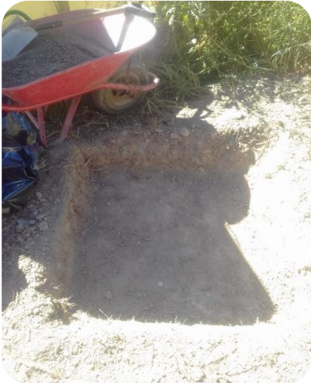
Foto 1. Preparación del área de desinfección del sustrato inerte de arena
