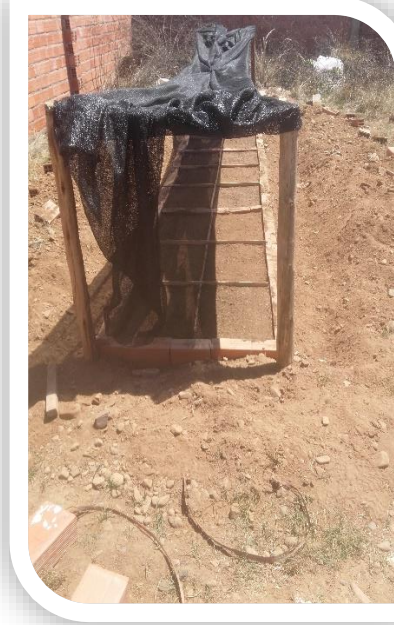
Construcción de la almaciguera
