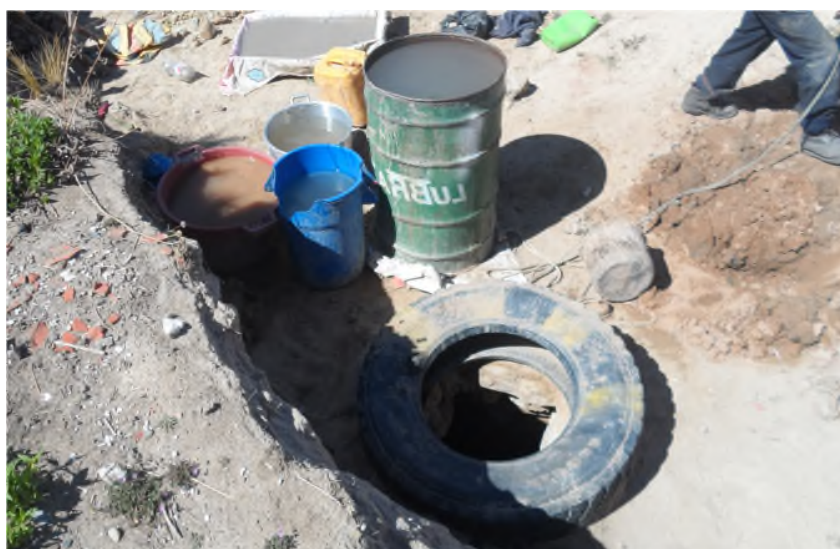
Figura 13. Pozo de agua en un domicilio de agua de la comunidad de Vila Ñeque. (Foto tomada en octubre 2017).
