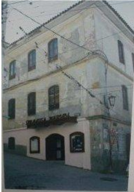
La Cinemateca cuando funcionaba en la calle Pichincha.
