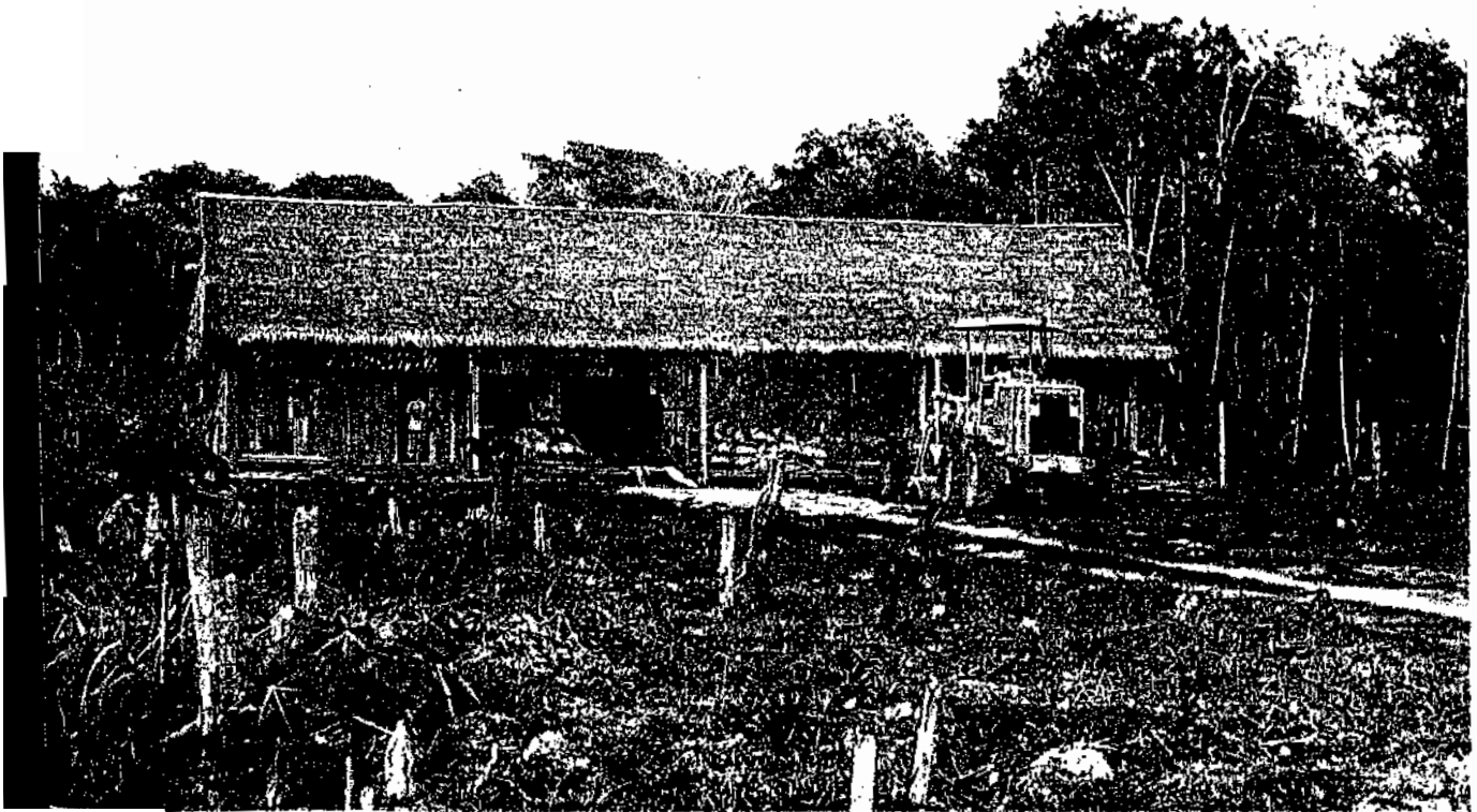
Instalaciones del Proyecto de Desarrollo Agrícola Rural Integrado "Puerto Rico"
