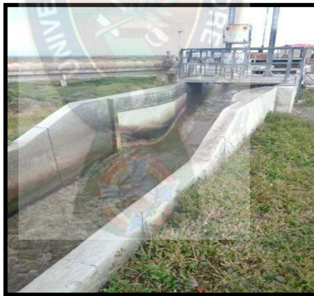
Ilustración 27 Punto de Muestreo - Afluente General (Canal Parshall).
