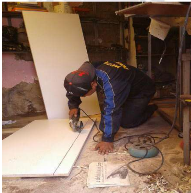
Figura 4.8 Corte de madera melaminica (Fuente: Elaboración Propia)
