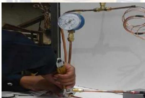
Figura 4.55 Instalación del manómetro de baja (Fuente: Elaboración Propia)
