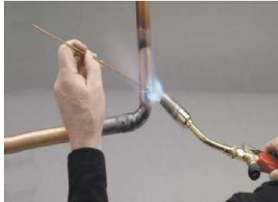
Figura 3.15 Unión de tuberías por soldadura (Fuente: http://empresaunirefri.com )
