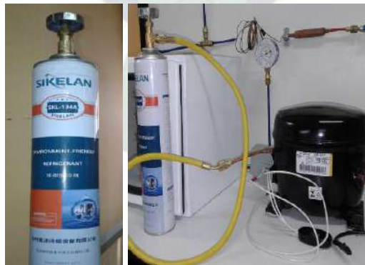
Figura 4.60 Carga del gas ecológico 134a al sistema (Fuente: Elaboración Propia)
