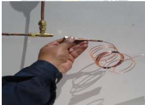
Figura 4.52 Instalación del Tubo Capilar (Fuente: Elaboración Propia)
