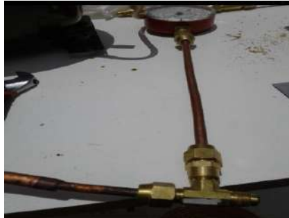
Figura 4.33 Instalacion de manometro de alta (salida del condensador) (Fuente: Elaboración Propia)
