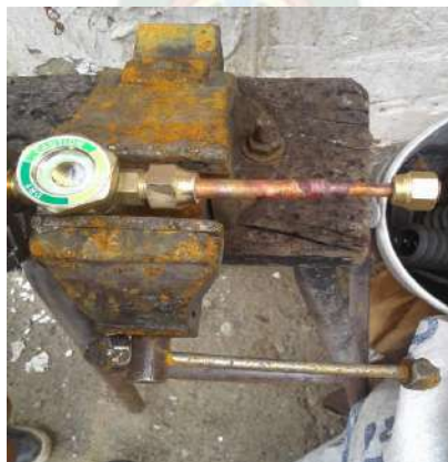
Figura 4.40 Visor de líquido preparado para su instalación (Fuente: Elaboración Propia)
