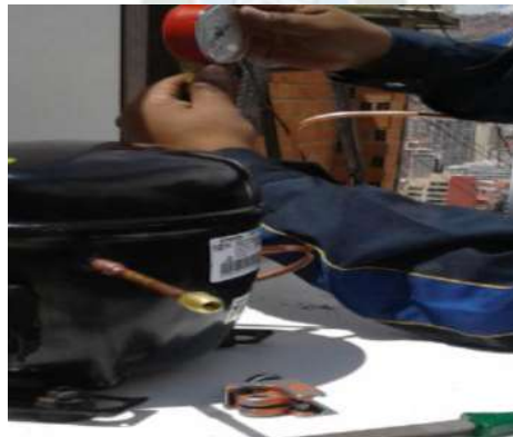
Figura 4.29 Instalacion del manometro de alta (Fuente: Elaboración Propia)
