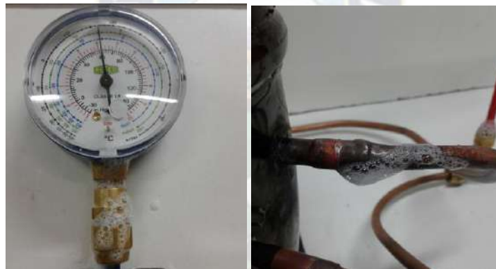
Figura 4.61 Prueba de fugas en el sistema (Fuente: Elaboración Propia)
