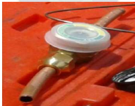
Figura 4.37 Visor de Líquido (Mirilla) (Fuente: Elaboración Propia)
