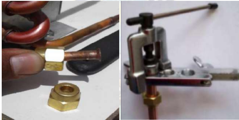
Figura 4.24 Avellanado de la tubería (Fuente: Elaboración Propia)
