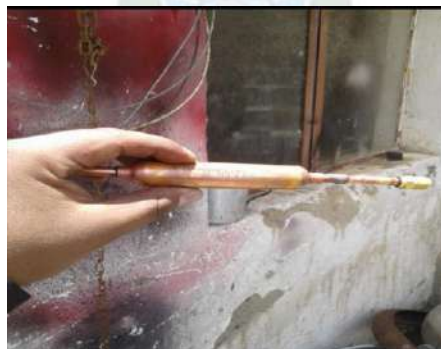
Figura 4.46 Unión de filtro con tubería para su instalación (Fuente: Elaboración Propia)
