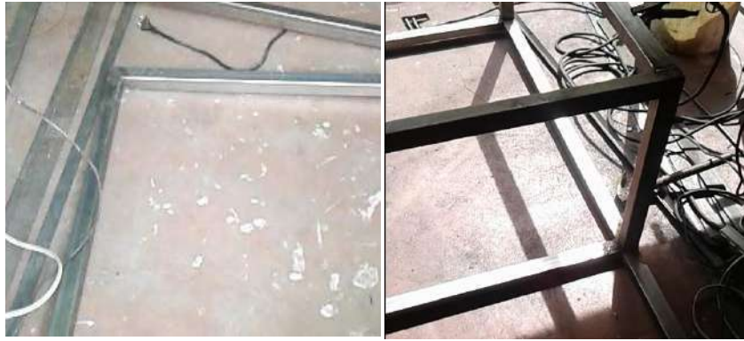
Figura 4.5 Montaje de la estructura del entrenador (Fuente: Elaboración Propia)
