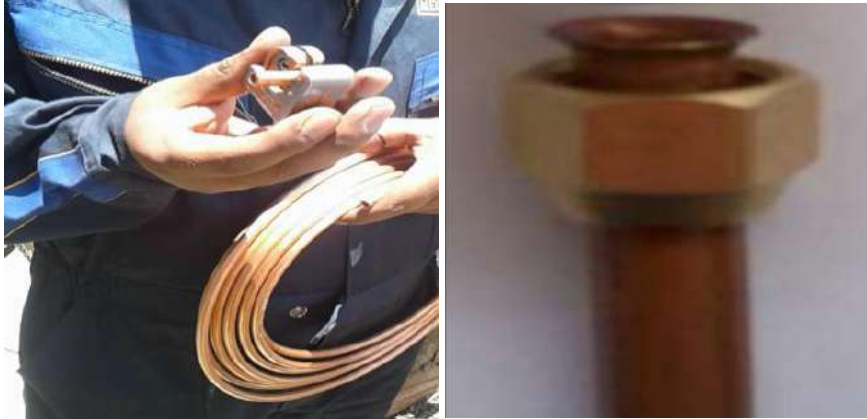
Figura 4.23 Operación preparado de tuberías (Fuente: Elaboración Propia)
