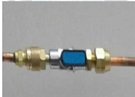
Figura 4.44 Válvula manual instalada (Fuente: Elaboración Propia)
