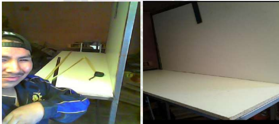
Figura 4.10 Montaje de la madera melaminica a la estructura metalica (Fuente: Elaboración Propia)
