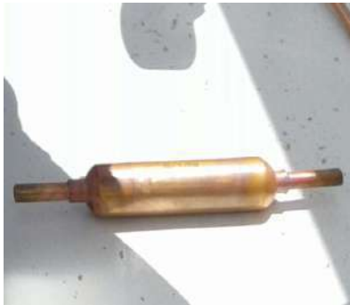
Figura 4.45 Filtro deshidratador (Fuente: Elaboración Propia)
