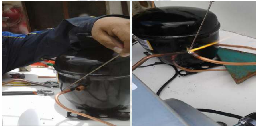
Figura 4.28 Preparacion de tubería y operación de soldadura (Fuente: Elaboración Propia)
