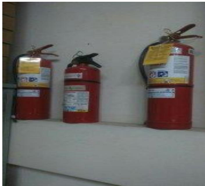
Fotografía 6 extintores de incendio de papel del Archivo Histórico de La Paz
