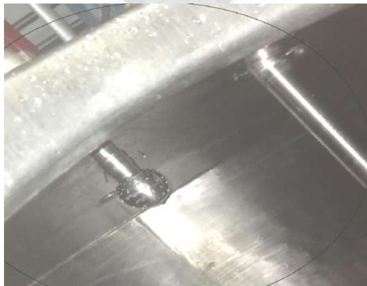
Figura 2. 6. Tanque elaboración con aspersor tipo bola
