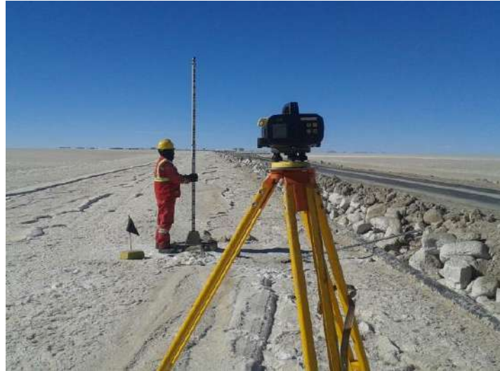
Fotografía N° 15 Nivelación Geométrica Circuito B Fuente: Propia
