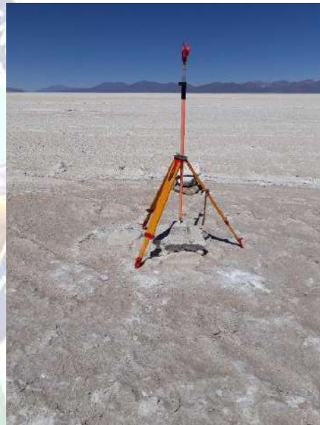
Fotografía N° 12 Instalación prismas Fuente: Propia
