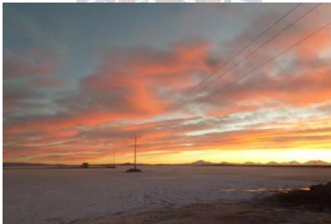
Fotografía N° 5 Reconocimiento red de electricidad Fuente: Propia
