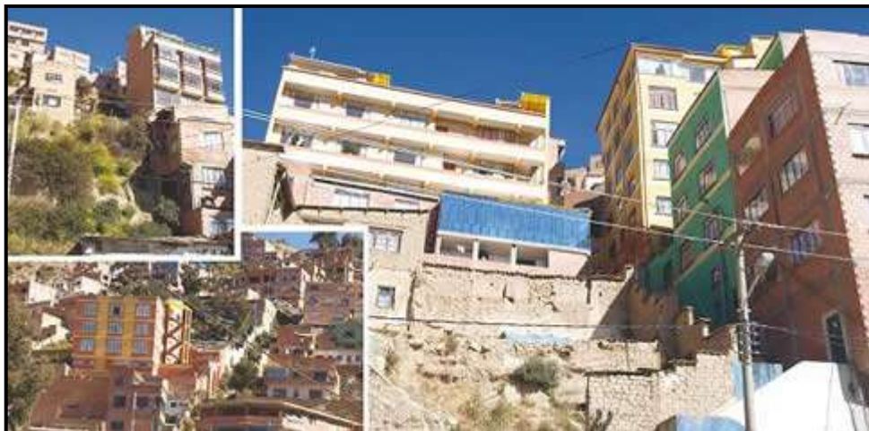
DEGIR: construcciones de más de tres niveles sobrecargan el terreno de algunas laderas generando un riesgo para sus propietarios y su vecindad
