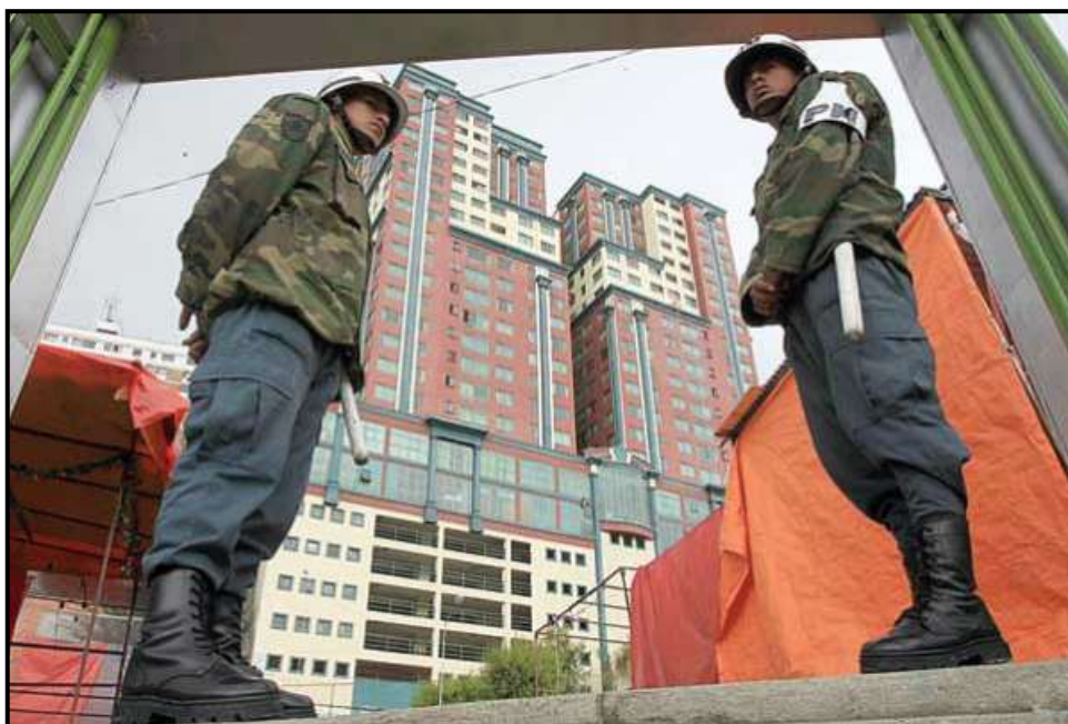
El edificio El Alcázar no cuenta con planos de construcción aprobados, según la Alcaldía de La Paz. ARCHIVO
