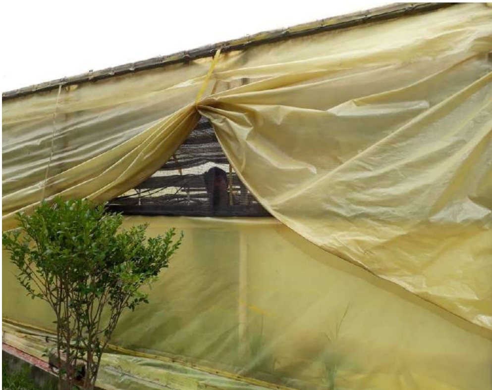
Foto 14. Personal abre de forma manual las ventanas laterales del invernadero Convencional.
