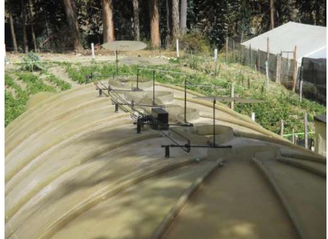
Foto 15. Ventanas cenitales abiertas por el mecanismo de piñón y cadena.
