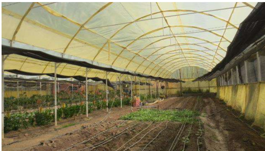
Foto 31. Vista interior del invernadero Convencional sin pantallas de sombreo.
