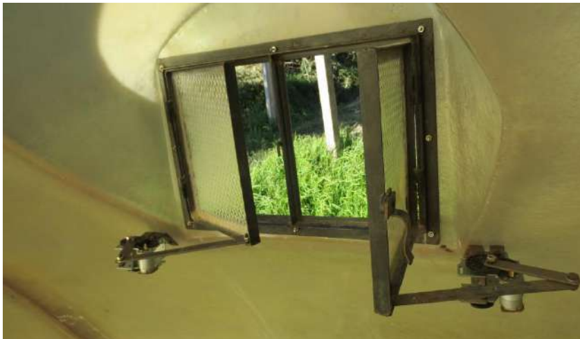
Foto 20. Ventanas laterales electromecánicas.
