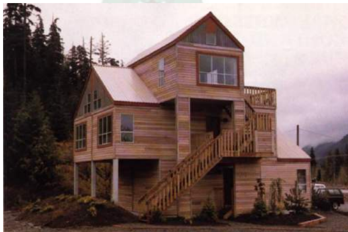
Figura 2 - 15: Construcción de casa de madera
