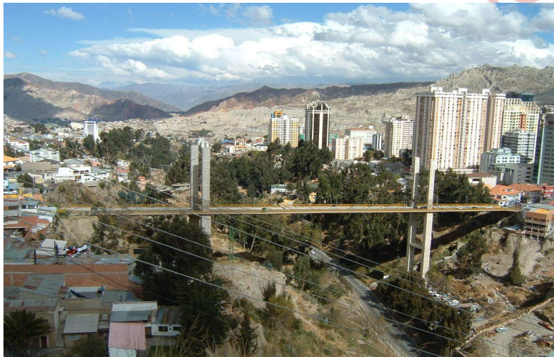
FOTOGRAFIA N° 2 PUENTE DE LAS AMERICAS
