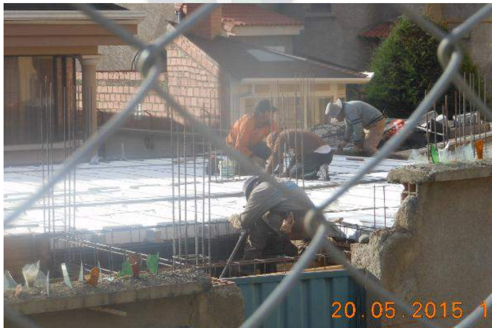
FIGURA Nro. 16 Fotografías de la conformación de la Cuadrilla para las Losa Alivianada H=20 cm.
