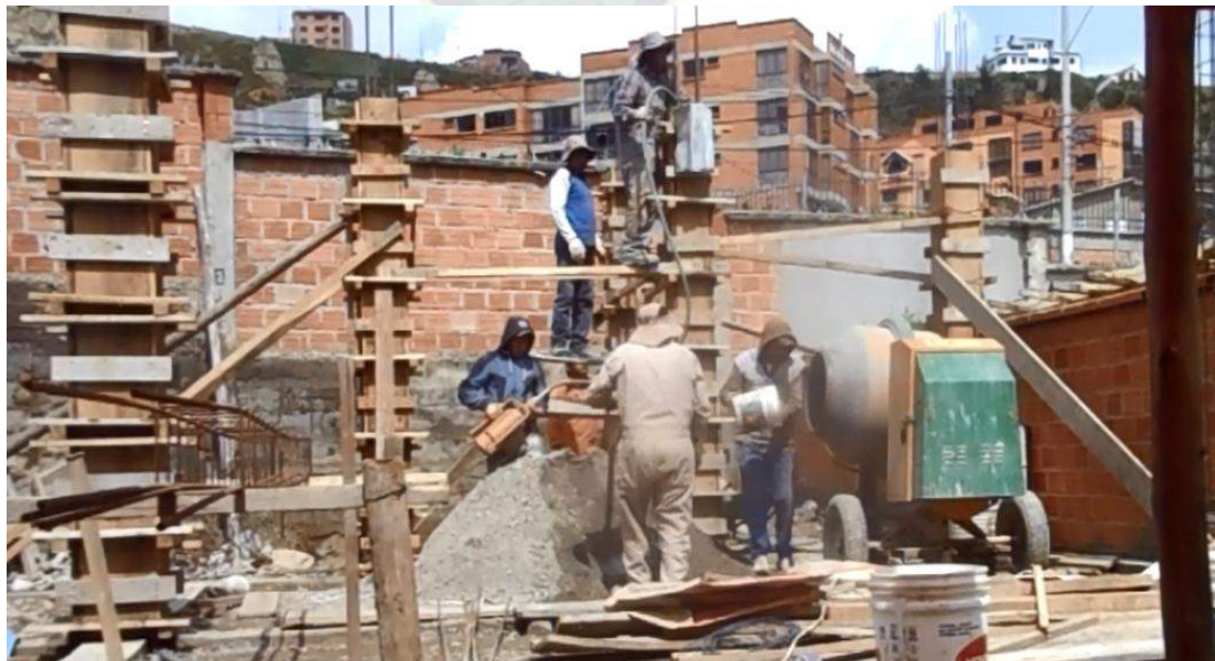
FIGURA Nro. 13 Fotografías de la conformación de la Cuadrilla para las Columnas de H.A.
