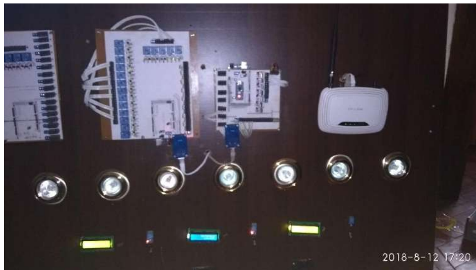
Figura 3.29a Tablero Demostrativo (Fuente: Autor)
