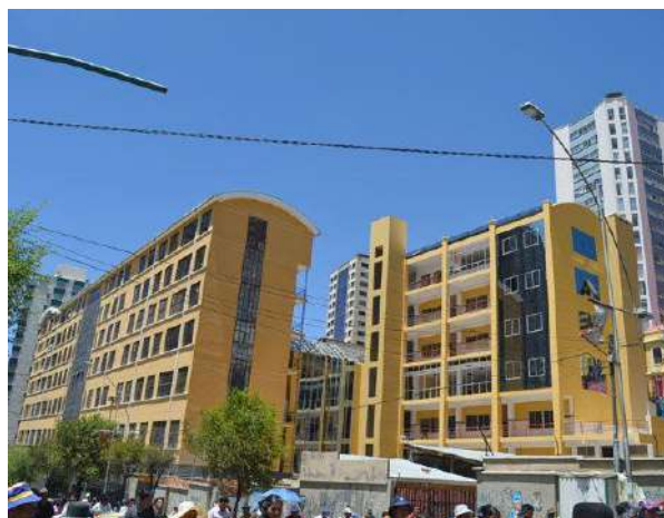
Figura 3.3 Facultad de Tecnología Edificio Bloque “B” (Av. Arce) (Fuente: Autor)
