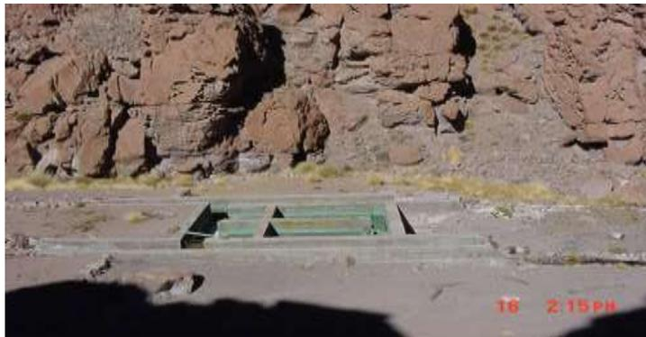
Desarenador en el Silala 1: obras de mampostería construidas por los chilenos para tratar las aguas de los manantiales del Silala. Claramente se puede observar que las ramificaciones por las cuales baja el agua, fueron construidas artificialmente. (Google Earth)
