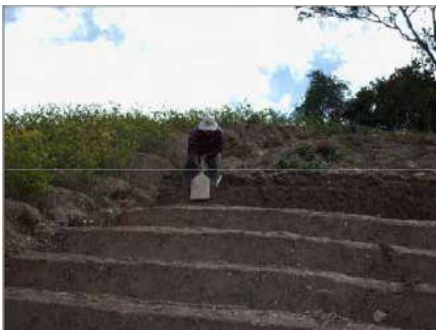
Construcción de Wuachus
