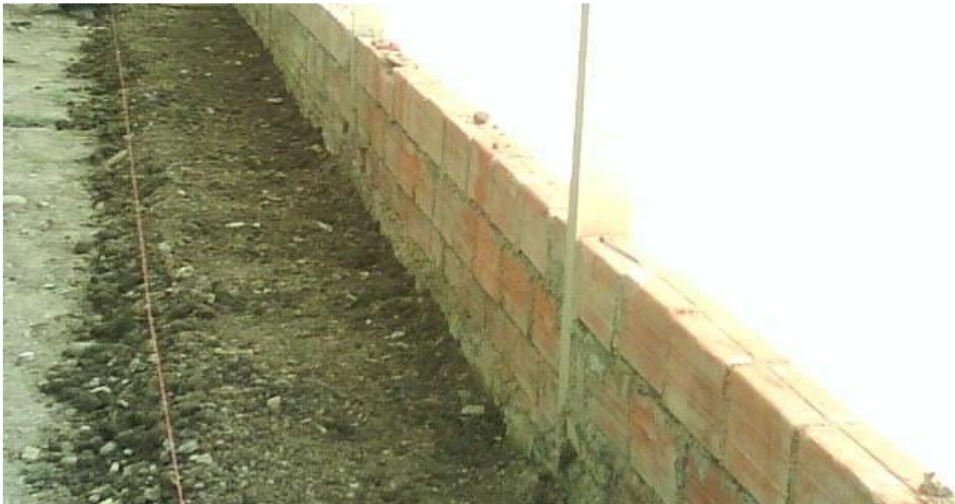
Foto 2. Remoción y nivelado del suelo experimental
