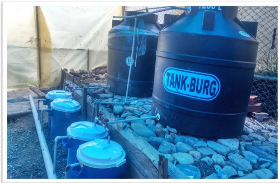
Figura 8. Armado e instalación de los biofiltros
