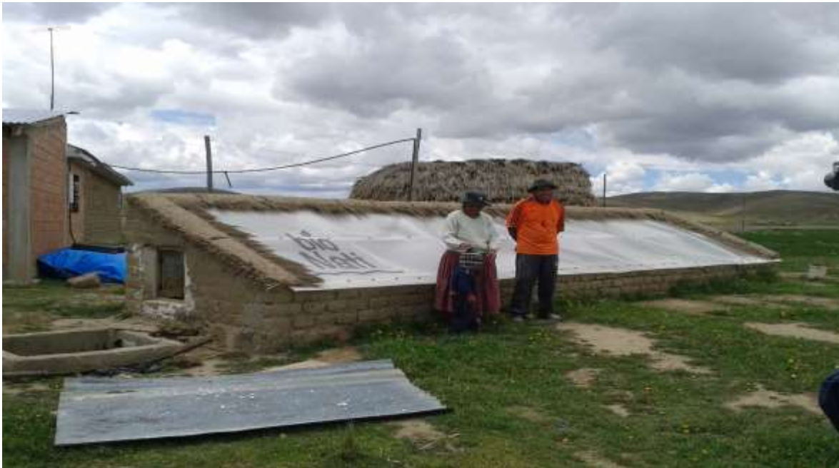
Gráfico 4: VISTA EXTERIOR - BIODIGESTOR TUBULAR
