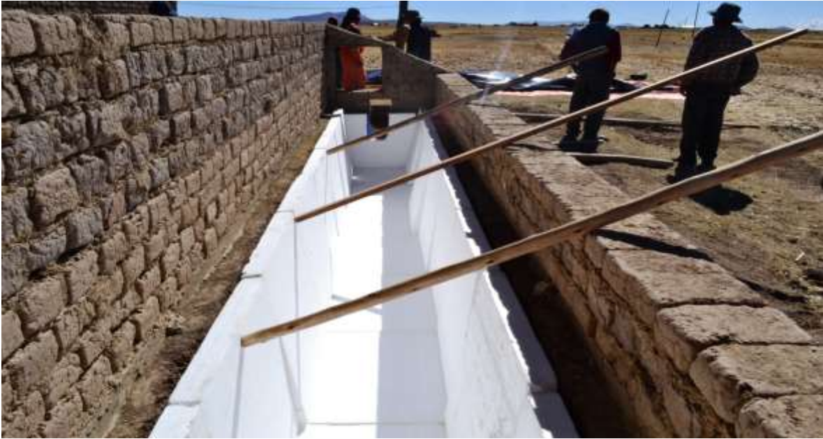
Gráfico 6: SISTEMA DE AISLAMIENTO TÉRMICO DEL BIODIGESTOR
