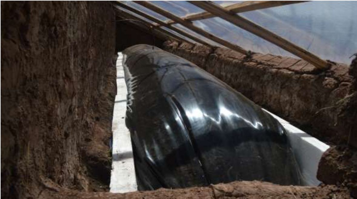
Gráfico 5: VISTA INTERIOR- BIODIGESTOR TUBULAR
