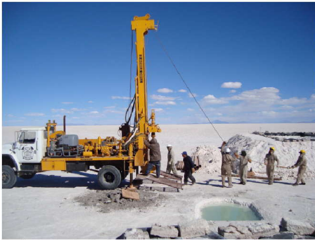
Trabajos de perforación en el Salar de Uyuni
