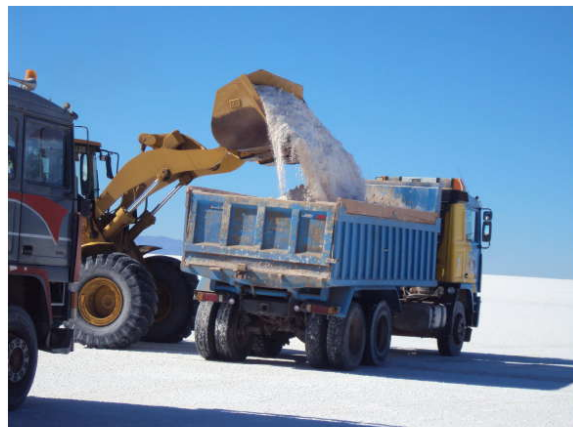
Construcción de los diques en el Salar de Uyuni
