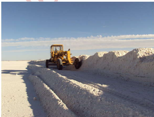
Construcción de los diques en el Salar de Uyuni
