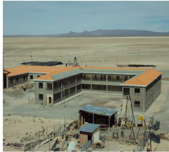
Vista panorámica de las obras civiles en la Planta Piloto
