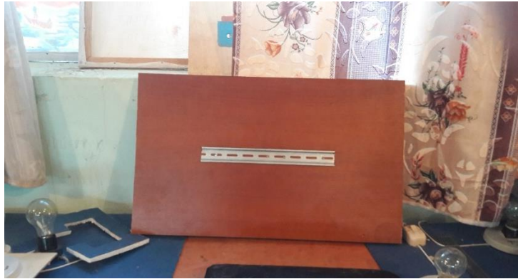
Figura # 15 Tablero Con El Posicionamiento
