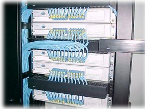
Figura 51: conexión de patch cord en switch
