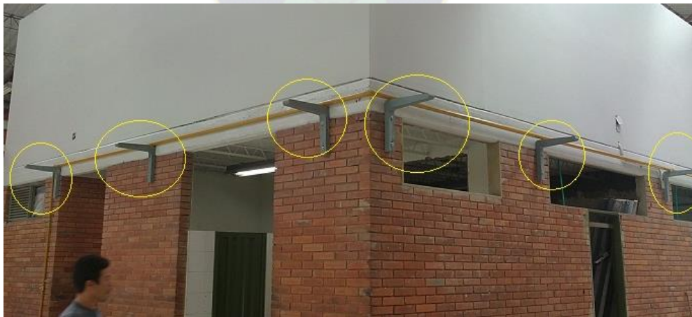
Figura 52: Distribución de red en escalerillas
