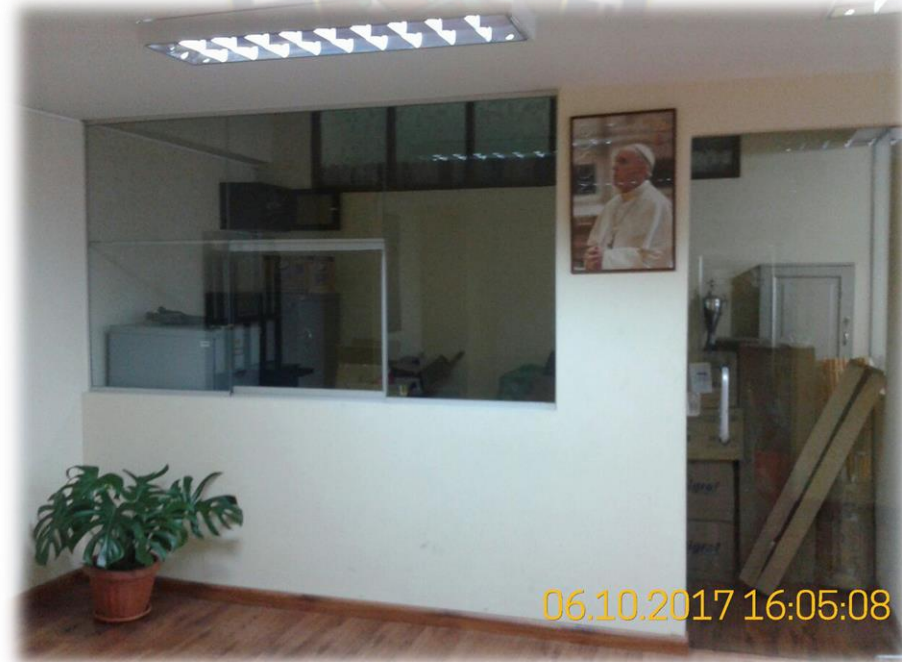
Figura 4: Gabinete de swich para piso administrativo
