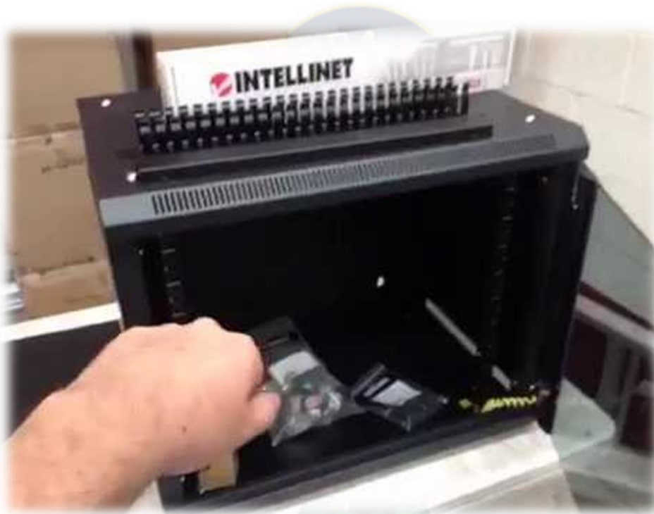
Figura 56: Montaje y armado del Rack de Comunicaciones y Patch Panel
