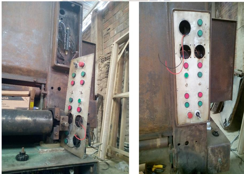
Figura 32 Tablero de mando en reconstrucción
