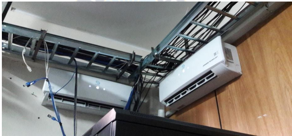
Figura 4.55 Escalerilla Cables UTP
