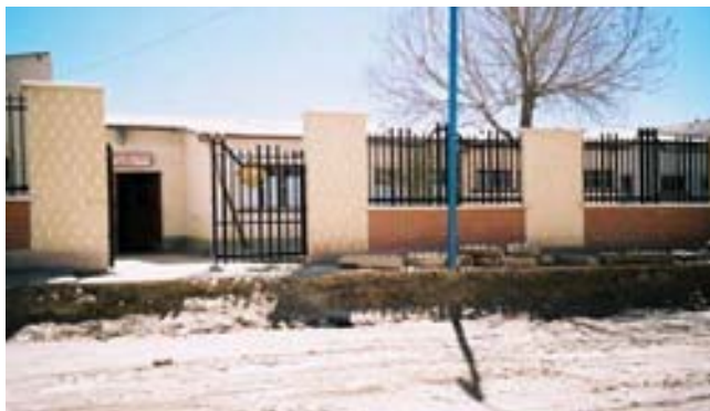
Fotografía N° 24. Centro de Salud Viacha
