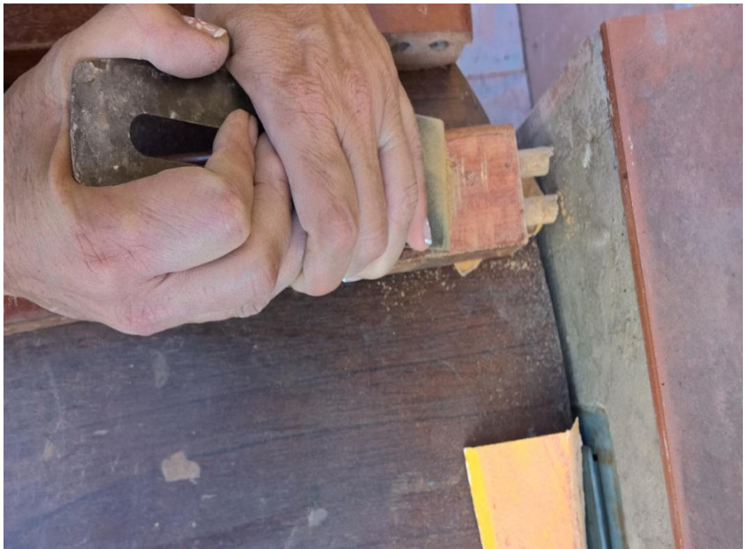
Imagen 10 (Desmontaje de estructura y lijado de piezas individual)
