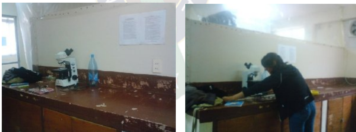
Fotografía 4.- Posiciones de los mesones contruidos en hormigón armado
