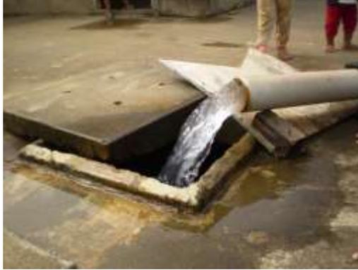
VISTA DE LA LLEGADA DE AGUA DEL SISTEMA DE BOMBEO AL TANQUE DE ALMACENAMIENTO
