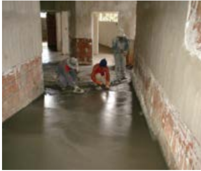
COLOCADO DE CERAMICA, VACIADO PISO Y CONTRAPISO
