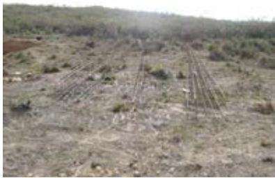
SE PREPARAN LOS FIEROS PARA LAS VIGAS CADENA
