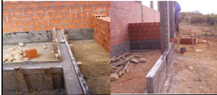
CULMINACION TOTAL DE LOS SOBRECIMENTOS, E IMPERMEABILIZACION
