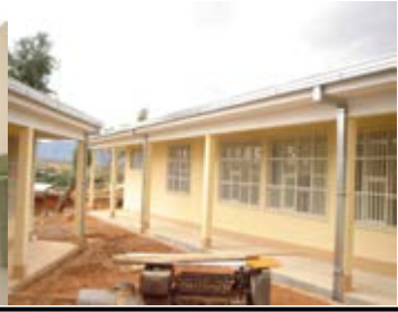
CORRECCION DE EMBOQUILLADOS DE TONOS DE CERAMICA Y REJAS EN VENTANAS
