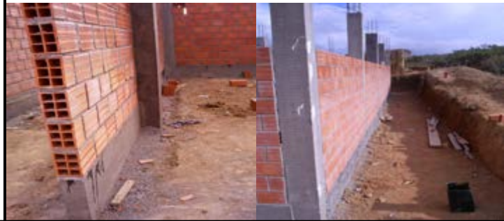
SE PREPARAN LOS FIEROS PARA LAS VIGAS CADENA
