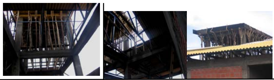
SE SUSPENDIERON LAS COLUMNAS PARA EL VACIADO DE LA LOSA DEL TANQUE DE AGUA
