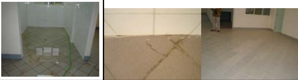
CORRECCIONES QUE SE DEBEN REALIZAR, DESNIVELES TONOS ROPTURAS DE CERAMICA
