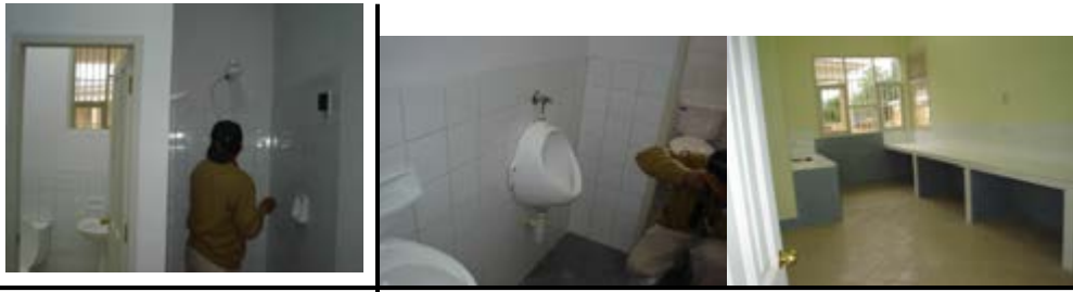
COLOCADO DE TODOS LOS ACCESORIOS SANITARIOS
