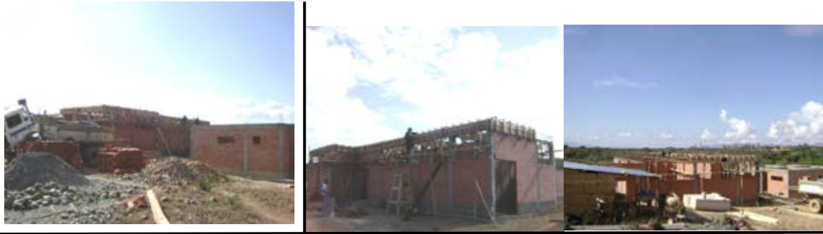
CULMINADO LOS MUROS CON LADRILLO VACIADOS DE LAS VIGAS CADENA
