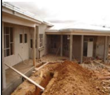
SE CONTINUA CON EL REBOQUE EXTERIOR, CUNETAS EN TODO EL
