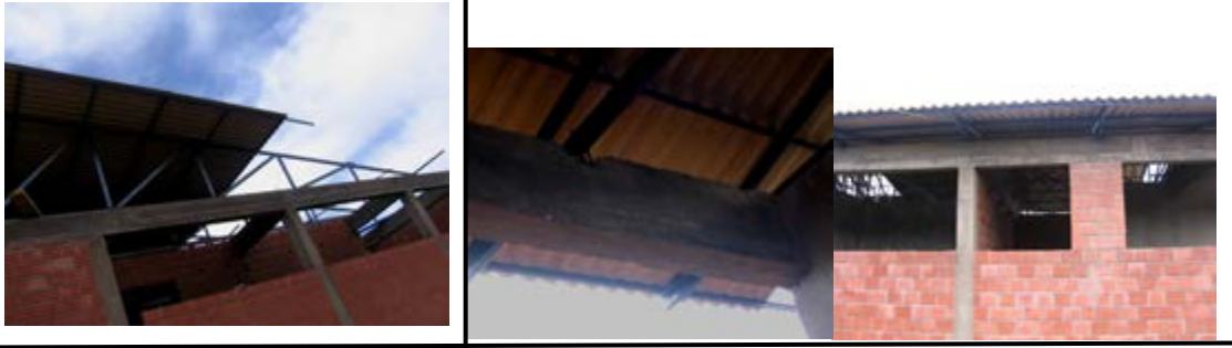
SE TERMINA DE DE ARMAR LA ESTRUCTURA METALICA PARA EL TECHADO
