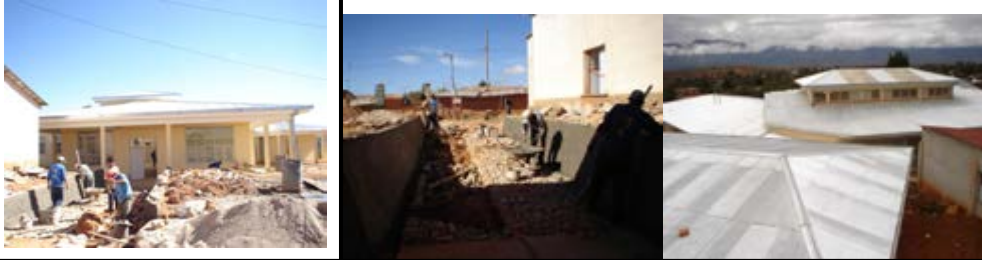
VACIADO MUROS DE H 2 O EN EL PRINCIPAL INGRESO, CUBIERTA CON
