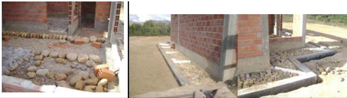
VACIADO DE CORDONES Y EMPIEDRE PARA POSTERIOR VACIADO
