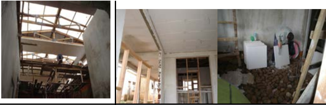
INICIO REVOQUES INTERIOR Y CIELOS FALSOS
