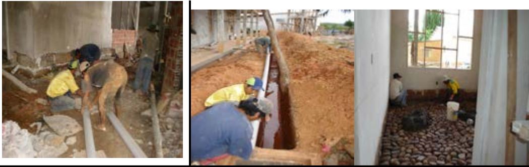
TENDIDO DE TUBERIAS DESAGUE SANITARIO Y PLUVIAL
