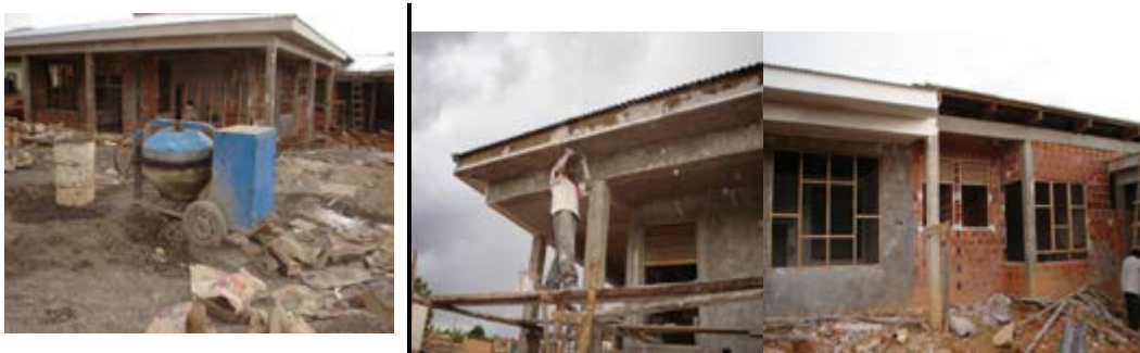
INICIO DE LOS REVOQUES EXTERIORES, Y LA PARTE DE LOS ALEROS
