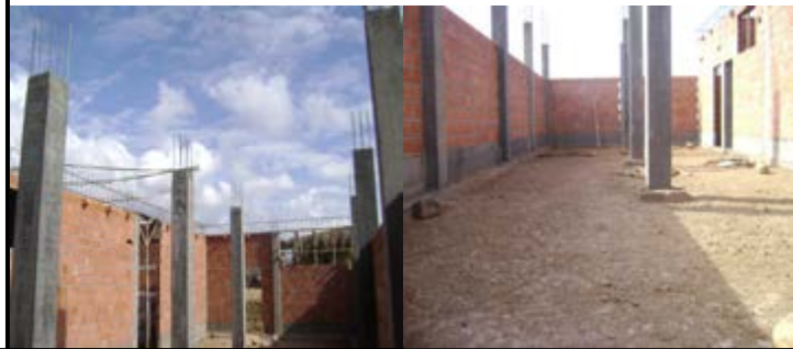
SE TIENE EL MATERIAL NECESARIO PARA PROSEGUIR CON LA OBRA
