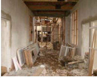
COLOCADO DE PUERTAS VENTANAS, REFUERZO CON PLANCHA EN
