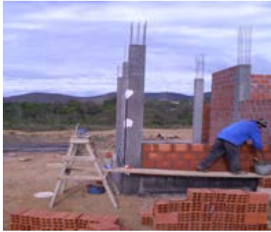
CULMINACION TOTAL DE LOS SOBRECIMENTOS, E IMPERMEABILIZACION
