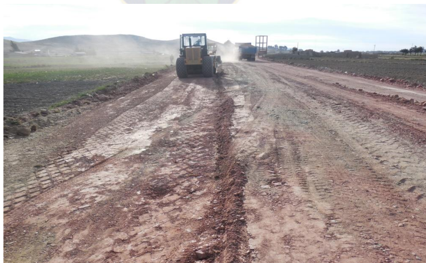
Fotografía N°4 Compactado del material
