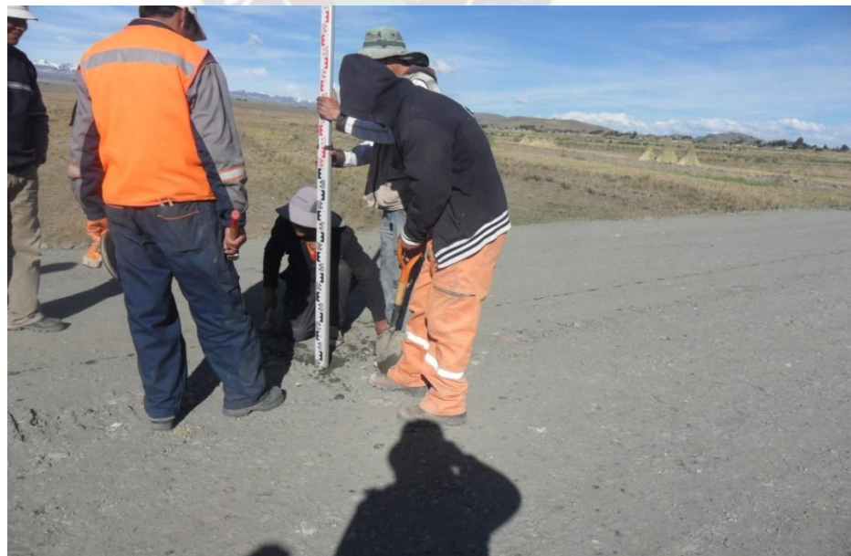
Fotografía N°11 Medición de la carretera
