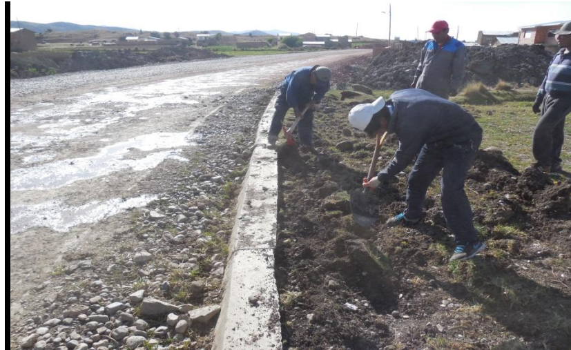
Fotografía N° 2 Colocado de pedraplen
