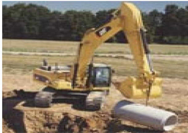
Figura: N° 6 Izado de tubería
