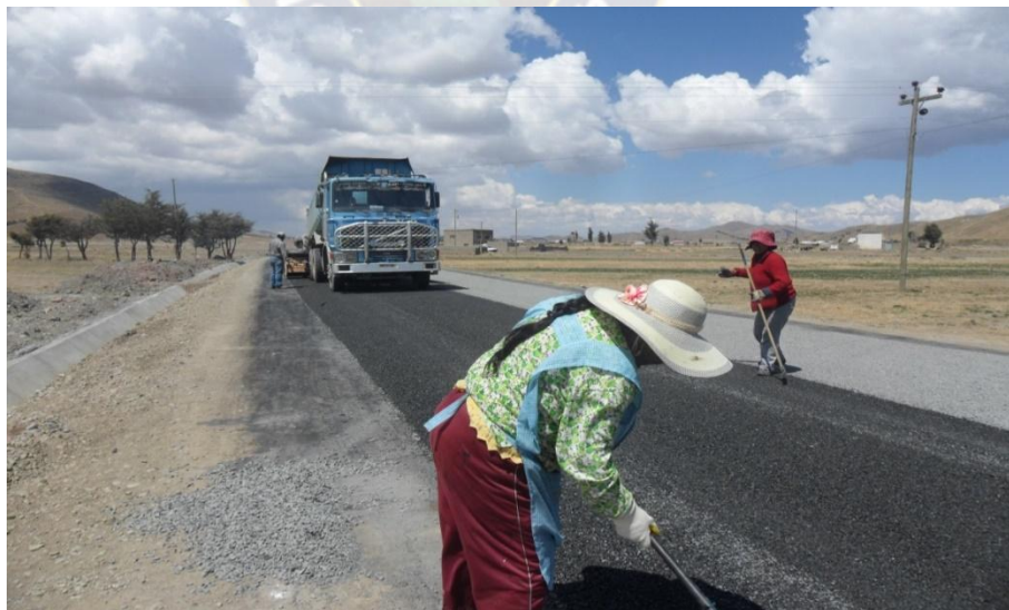
Fotografía N° 6 Barrido manual de gravillas 3/4 ”y 3/8”
