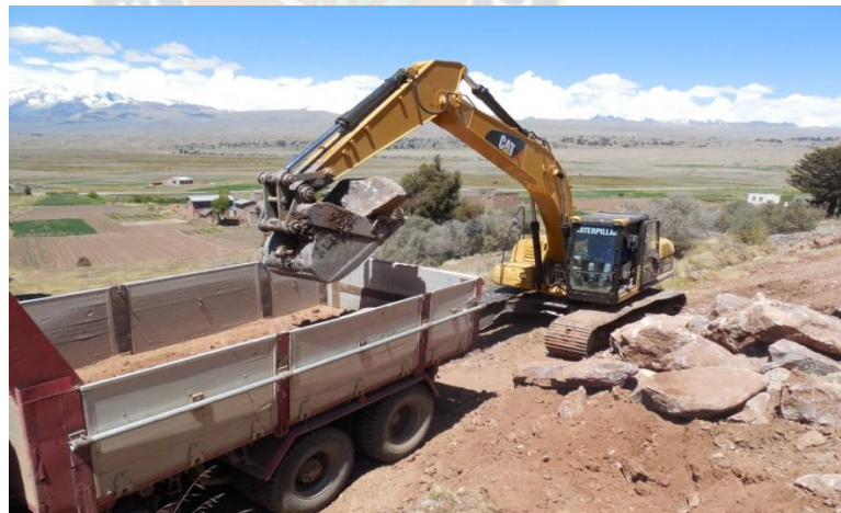
Fotografía: N° 31 Traslado de Pedraplen
