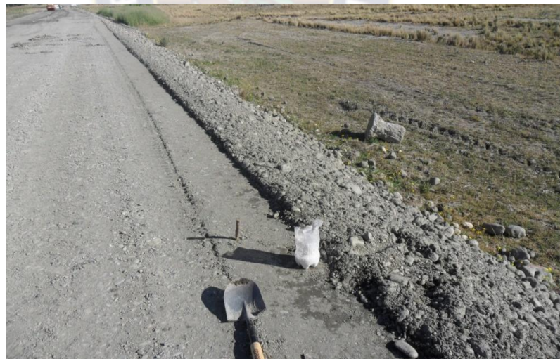
Fotografía N° 9 Estacas para la nivelación
