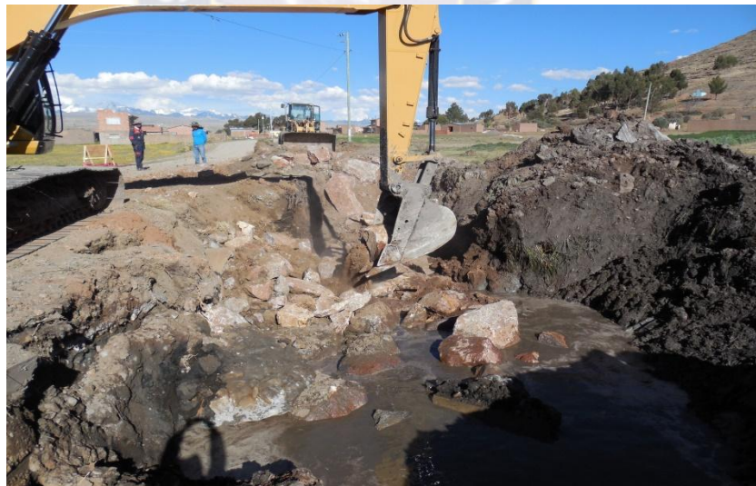
Fotografía N° 2 Colocado de pedraplen
