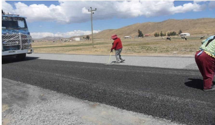
Fotografía N°5 Extensión de gravillas
