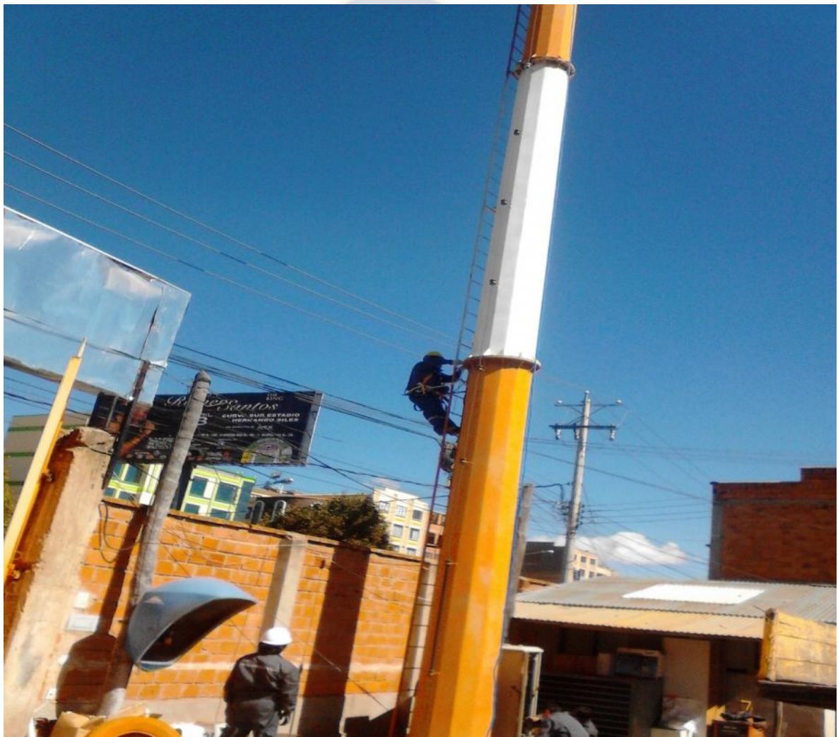
Fig. 3.6 Comienzo del desmonte de la antena de DECTLink en Gran centro III. Fuente: Foto Propia (Pasantía)
