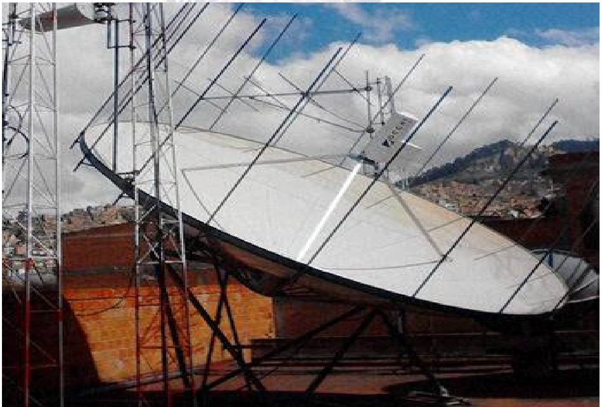
Antena receptora de señales satelitales armada con una jaula de Faraday para sufrir menos interferencia
