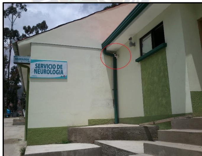
Figura 3.25 Cámara instalada en Neurología
