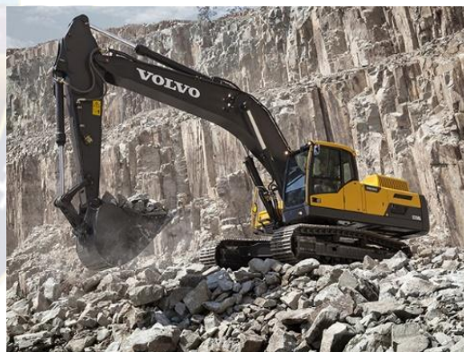
Figura Nro. 2 Excavadora sobre oruga
