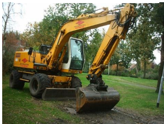
Figura Nro. 1 Excavadora sobre neumáticos
