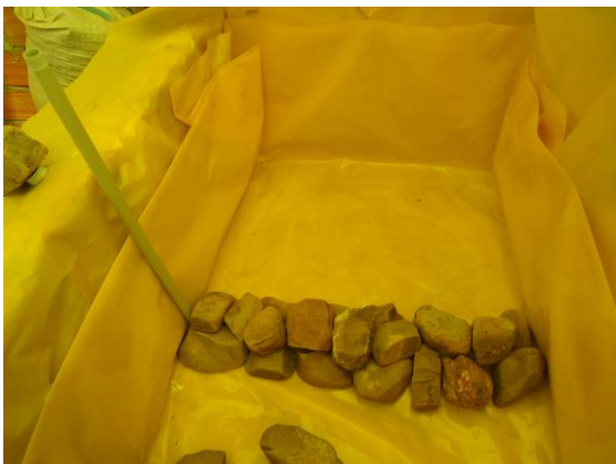
Impermeabilización de las cámaras de sub-irrigación y posicionamiento del tubo de alimentación de agua
