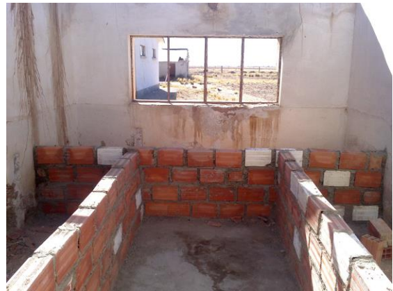
Cámaras de sub-irrigación concluidas
