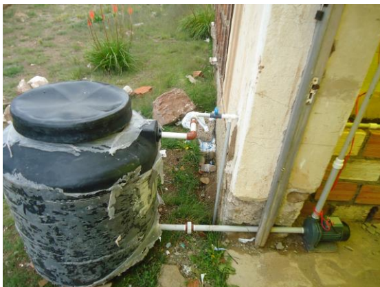
Instalación del sistema de nebulización
