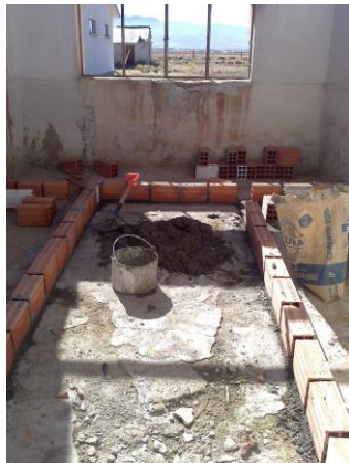
Inicio de construcción de las camas de propagación
