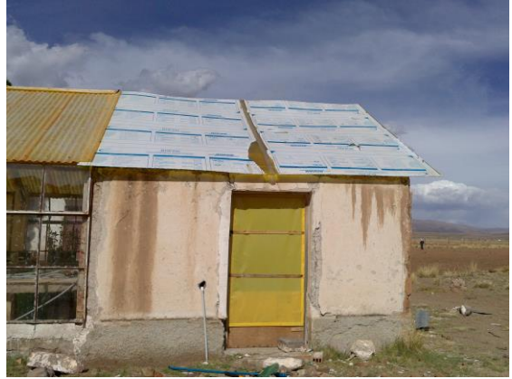
Predio de trabajo refaccionado
