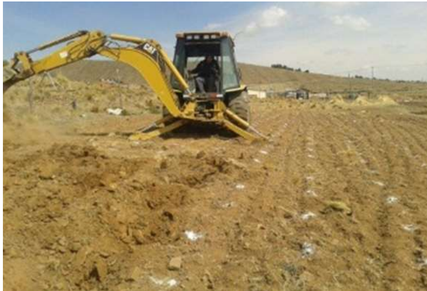
Figura 7. Realizado de hoyos con la maquinaria
