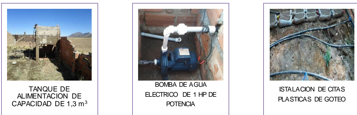
Figura 8. Proceso de instalación del sistema de riego por goteo.
