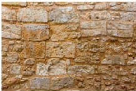
Silería con Cemento
