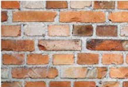
Ladrillo sin Revoque
