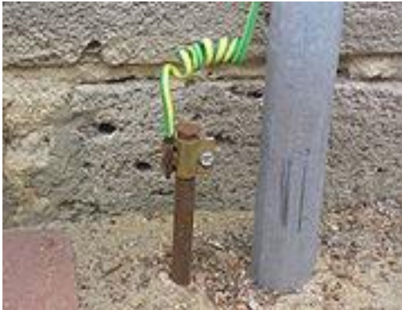
Fig. 13 A INSTALACION PUESTA A TIERRA
