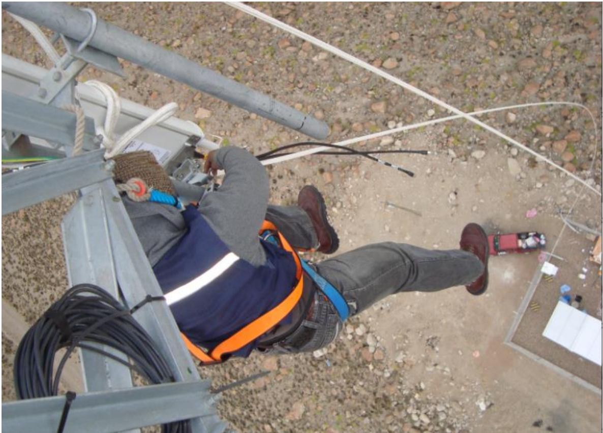
Figura 41. Montaje de una antena sectorial a los 100 mts (Fuente: Propia).
