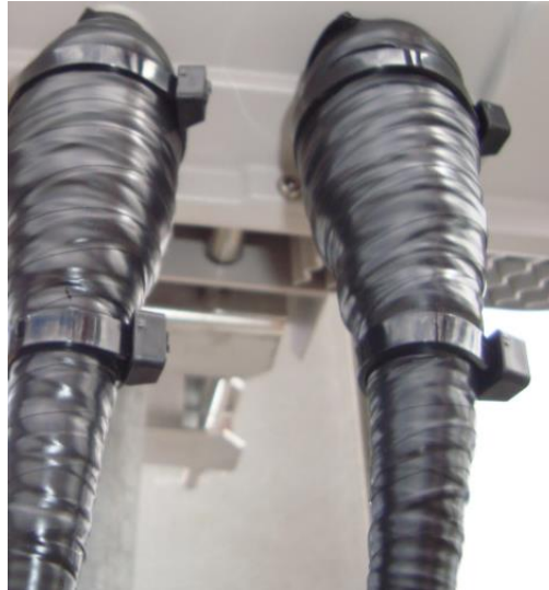
Figura 36. Conectores de la antenna vulcanizados (Fuente: Propia).
