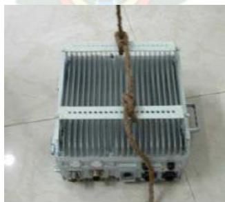
Figura 39. Equipo listo para ser enviado para su posterior montaje en la torre (Fuente: Manual de instalación ZTE UMTS).
