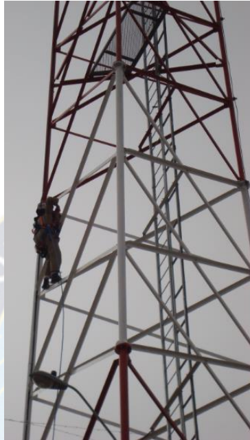
Figura 38. Técnico ascendiendo por la parte externa de la torre subiendo soga y roldana (Fuente: Propia).
