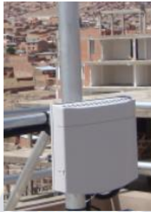
Figura 48. MU correctamente montada en el soporte outdoor (Fuente: Propia).
