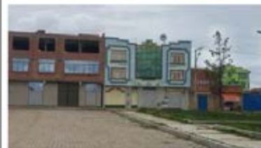
Construcciones de 3 y 2 pisos de ladrillo con y sin fachada.
