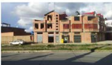
Construcción de 3 pisos de ladrillo sin fachada.
