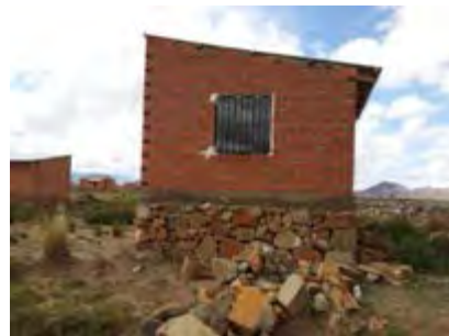
VIVIENDA LADO NORTE
