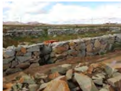
CIMIENTO DEL MURO PERIMETRAL
