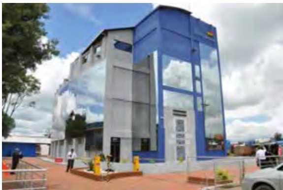
Fuente: Aduana Nacional de Bolivia Edificio de Archivo - Cochabamba
