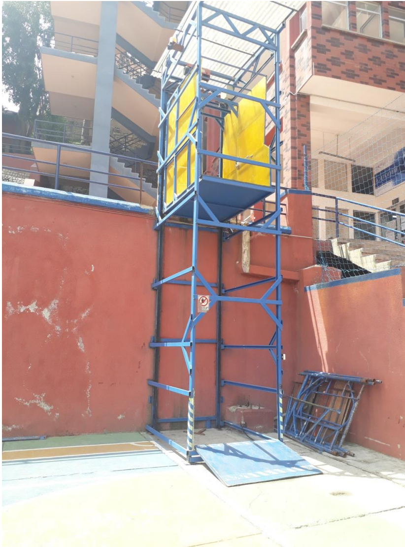
Descripción: Adaptación con un ascensor para personas con discapacidad física en el área deportiva.
