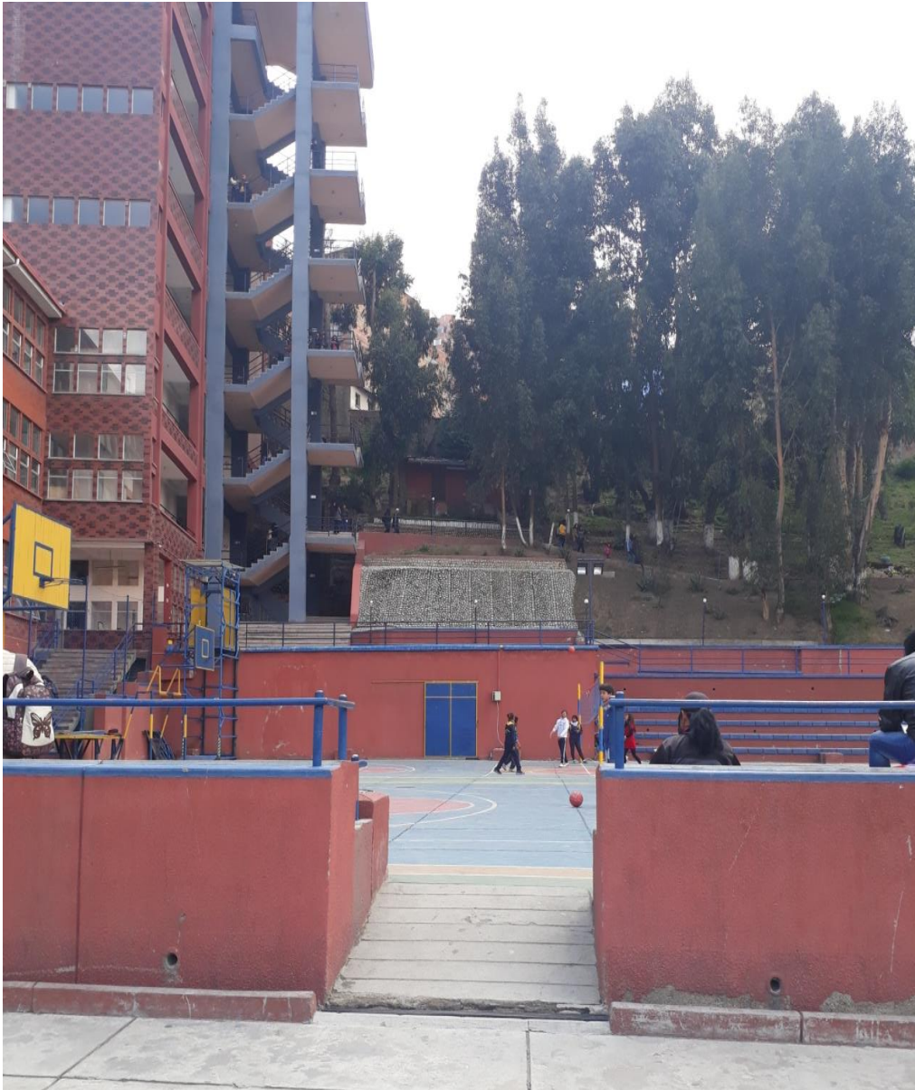
Descripción: Rampa de acceso al área deportiva.
