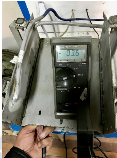
IMAGEN 4: Lectura de temperatura en evaporador Fuente: Elaboración propia
