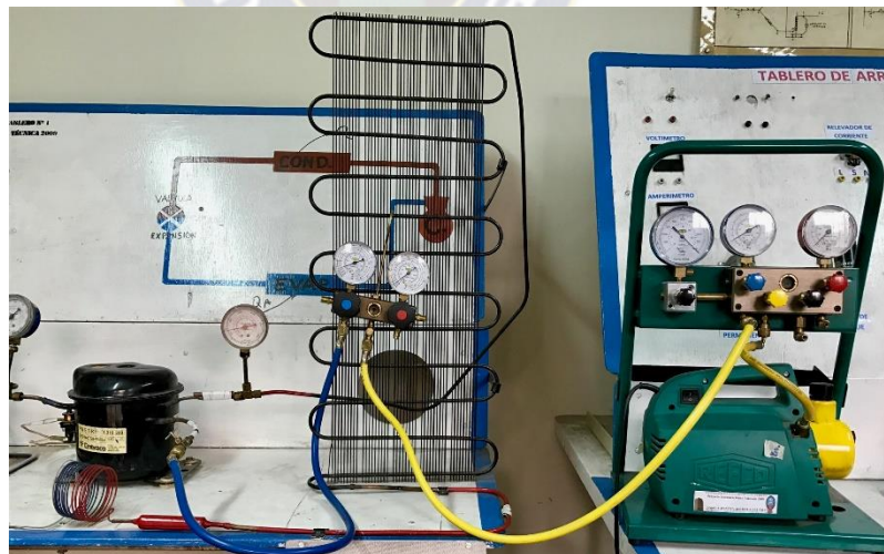
IMAGEN 5: Conexión de la bomba de vacío al sistema. Fuente: Elaboración propia
