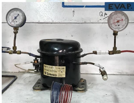
IMAGEN 2: Instalación de los manómetros fijos Fuente: Elaboración propia
