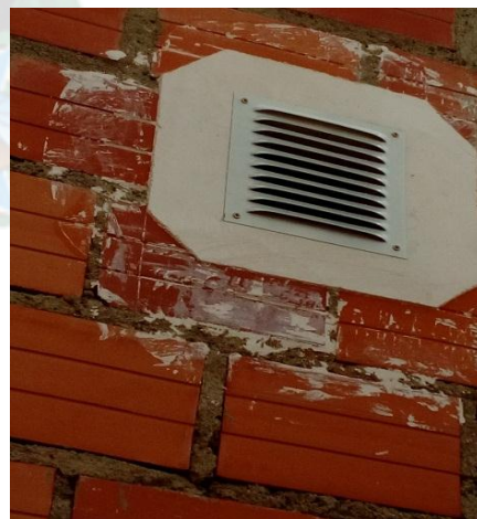
FOTOGRAFIA 1. Rejilla de salida de los productos de combustión.
