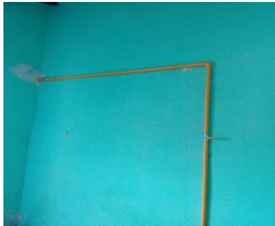
FOTOGRAFIA 1. Cruce de muro.
