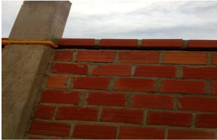
FOTOGRAFIA 1. Tubería empotrada.
