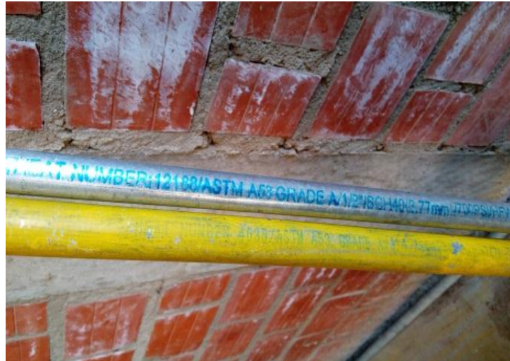
FOTOGRAFIA 1. Tubería galvanizado.
