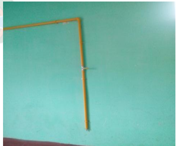
FOTOGRAFIA 1. Tubería en elevación.
