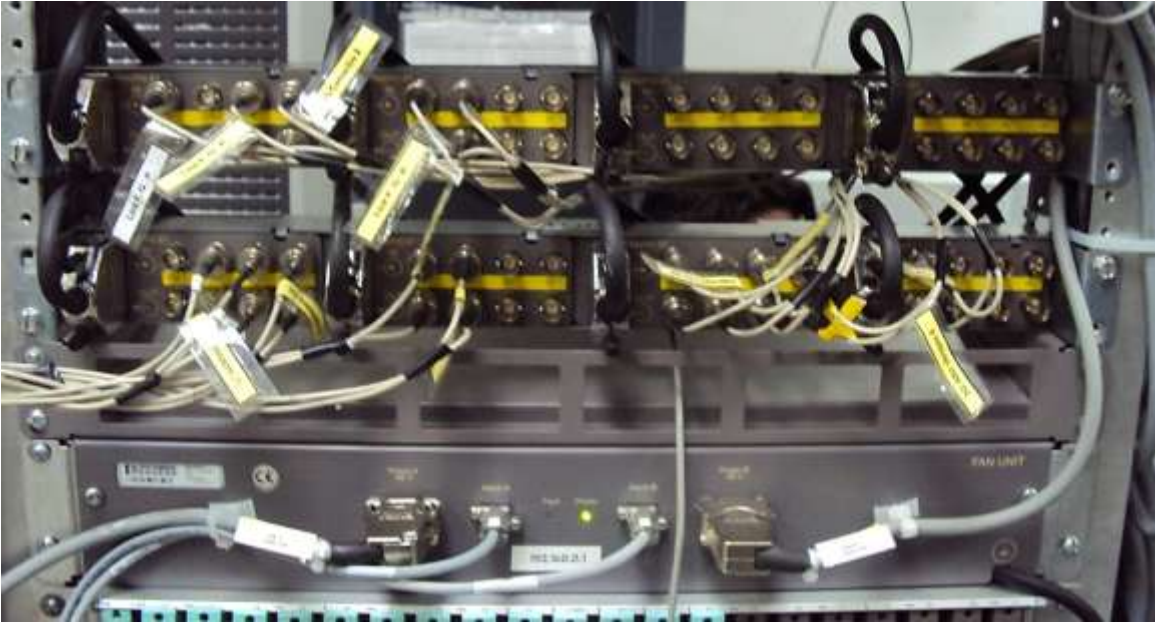
Figura 5.18: Conexiones en el DDF de las diferentes estaciones.
