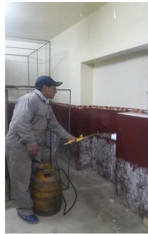
Figura 6. Flameado de paredes
