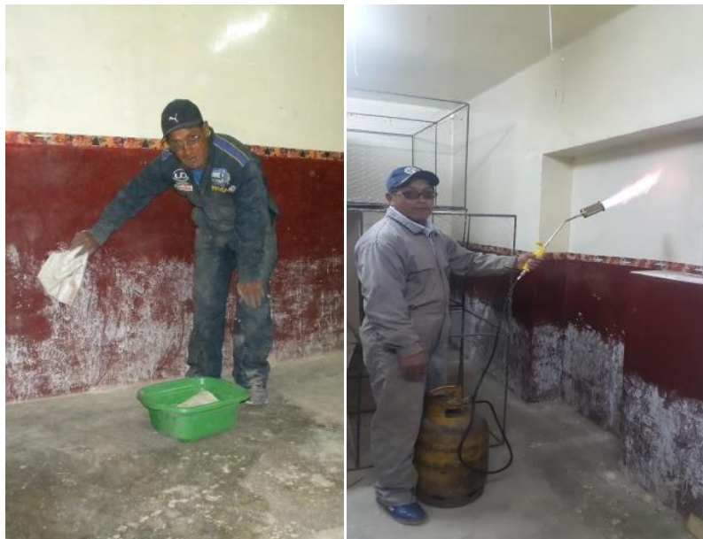
Figura 10. Encalado y flameado al Interior del Galpón
