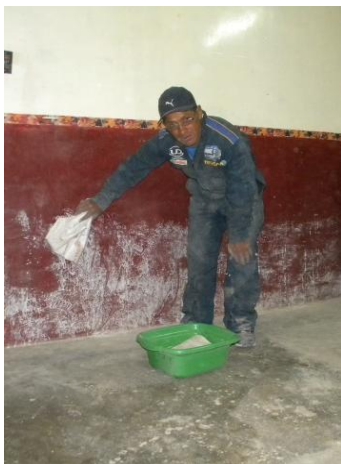
Figura 5. Encalado de Paredes
