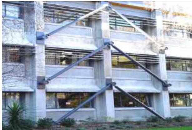
*(Ejemplo de rehabilitación mediante el agregado de riostras de acero.)*
