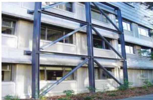
*(Vista de un pórtico arriostrado utilizado para la rehabilitación de una estructura existente de hormigón armado.)*
