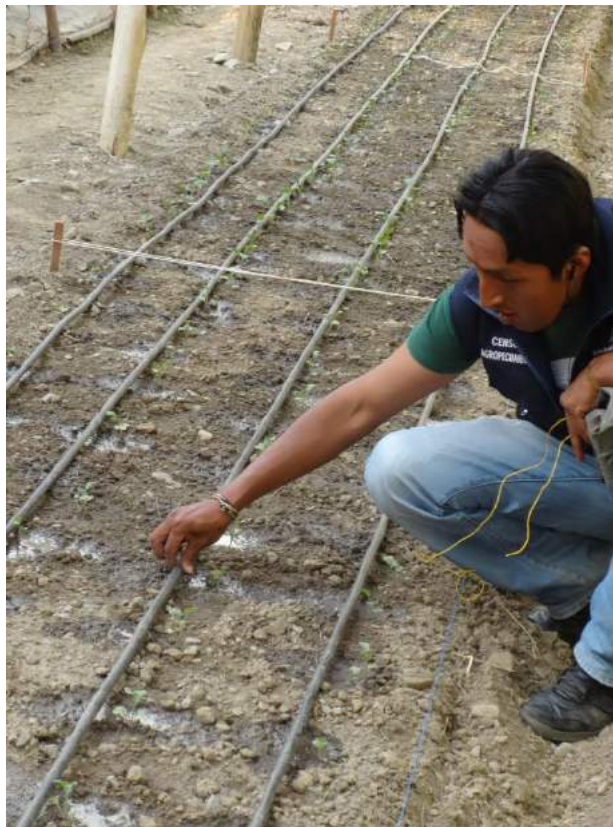
Figura 8. Instalación del sistema de riego por goteo
